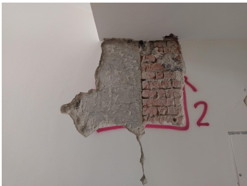
Slika 7.5 Sondažna bušotina 2 – Zid od pune opeke uz armiranobetonski stup
