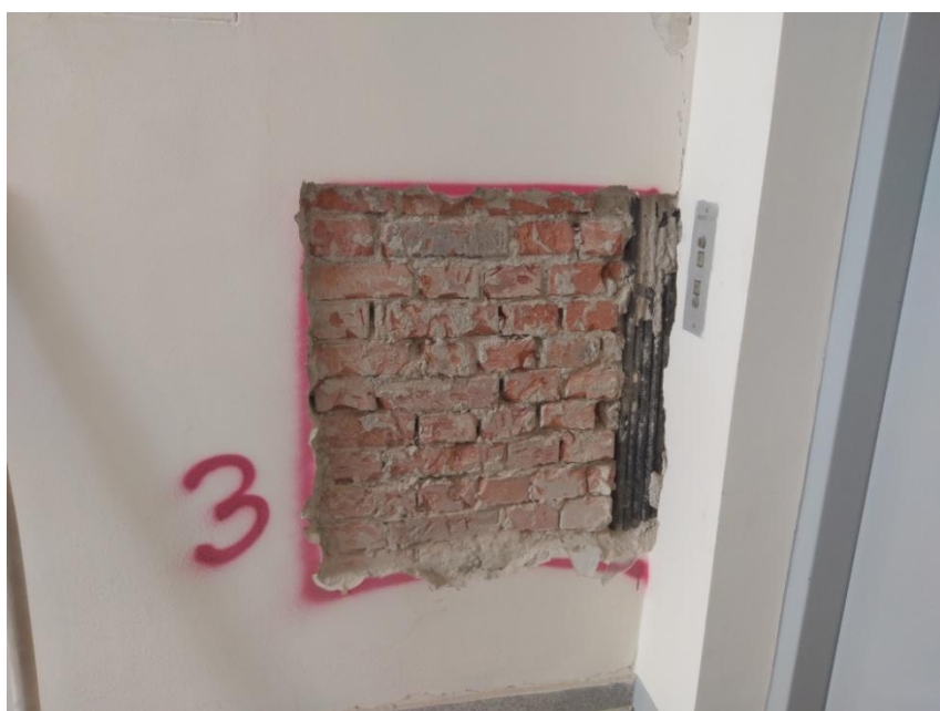
Slika 7.6 Sondažna bušotina 3 – Zid od pune opeke
