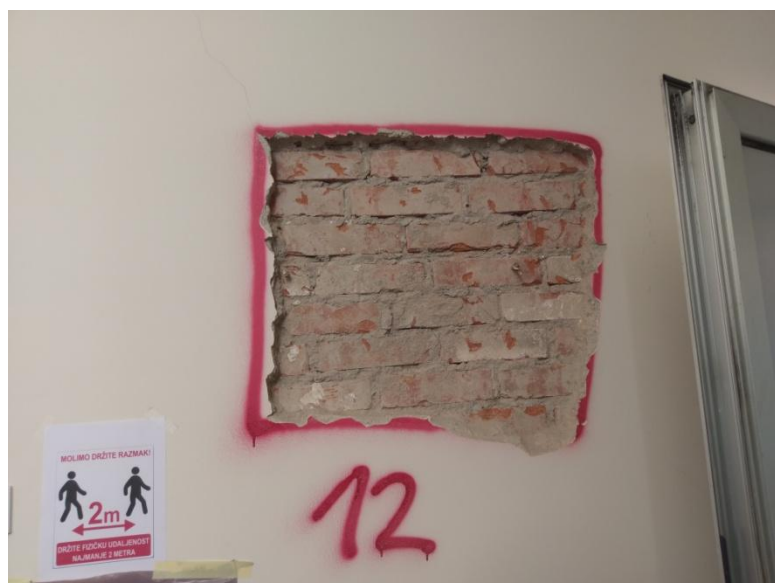
Slika 7.3 Sondažna bušotina 12 – Zid od pune opeke
